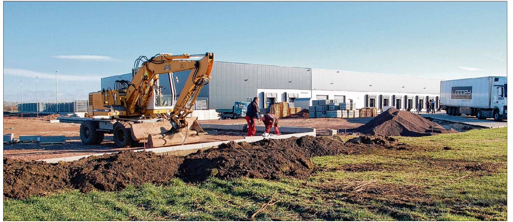
Bis Ende des Jahres entsteht bei „Florpartner“ ein neuer Bürotrakt, auch mit Sozial- und Ruheräumen, für 15 Mitarbeiter.
